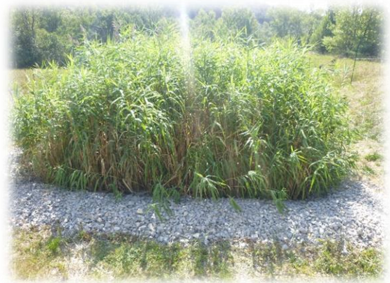
Photo 1 : Lagune aérée du Village (à gauche) et filtre planté de roseaux (à droite)
